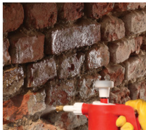
Aplicação de Consolidante 8020
